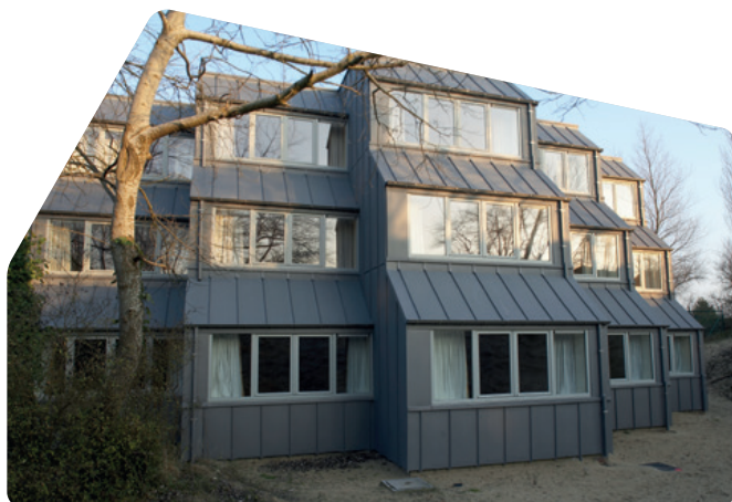
Vakantiecentrum Ter Helme, België Aspect: QUARTZ-ZINC® PLUS
