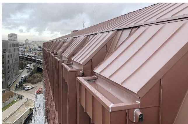
Crédit photo VMZINC® - Photographe Agence Anne CARCELEN Architecte Anne CARCELEN
