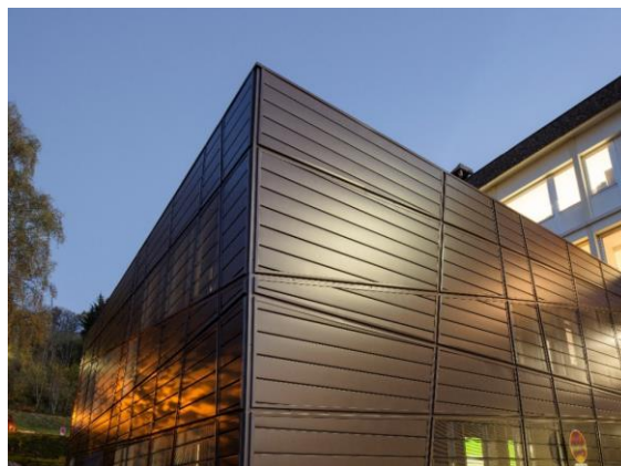
Maison de la santé « Gentiane », Riom es Montagne (15) Crédit photo : VMZINC® - Trinh et Laudat Architectes
