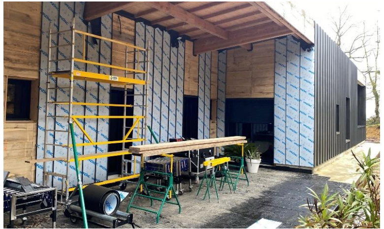
Crédit photo VMZINC® - LES COUVREURS DU CAUSSE
