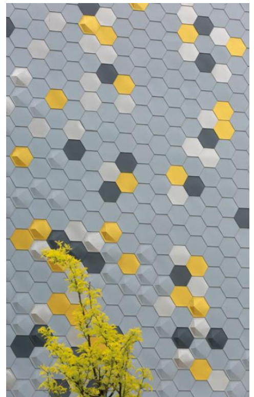
Cinéma à Basildon, Royaume-Uni Agence d'architecture : Pollard Thomas Edwards Crédit photos : VMZINC - Photographe Paul Kozlowski
